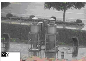
在溢达集团的工厂，各车间均安装了抽气系统，收集到处乱飞的棉花灰尘或纤维。收集所得的废气在排放入大气前，需要通过旋风式分离器。旋风式分离器内含棉花及纤维的水，被送往溢达集团污水处理厂进行处理，处理后的水可再用于洗涤器。
