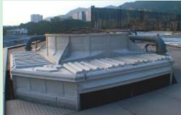
太古在又一城設置的冷凍裝置，是當時最大的氣冷式改造為水冷式系統。
